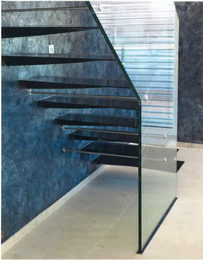
/ Freitragend die Wand entlang: Die einzelnen Stufen sind einseitig, mittels je drei in den Stufenkörper eingeklebter Gewindestangen an der Wand befestigt.
