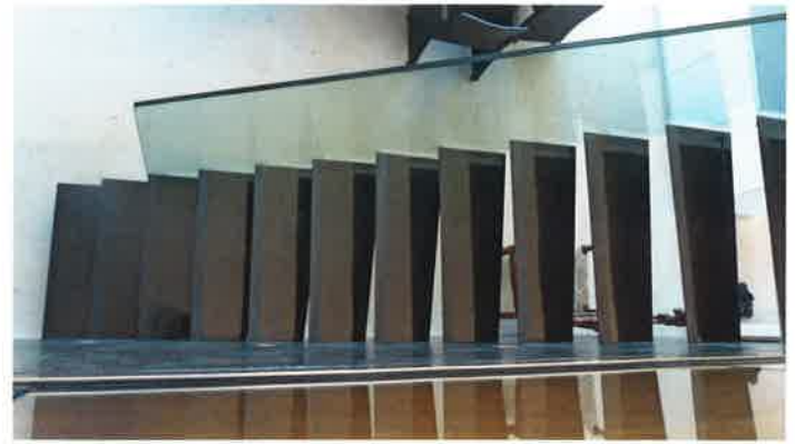
/ Sicherer Aufstieg: An der Vorderkante erhalten die hochglanz lackierten Stufen zur Rutschhemmung sogenannte Gleitschutzstreifen.
