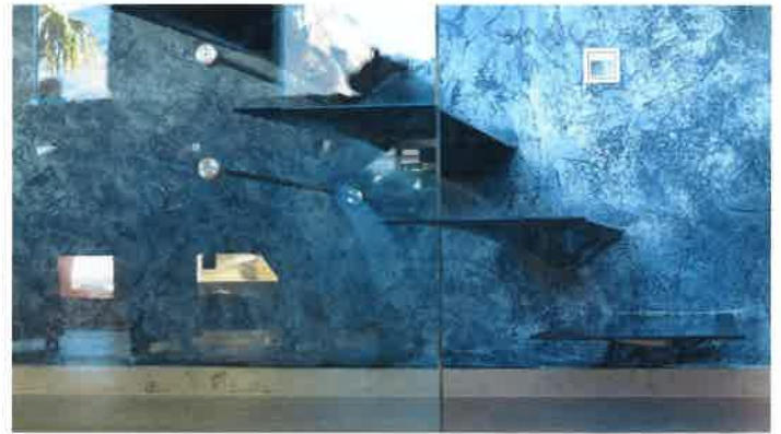
/ Feine Treppenskulptur: In der Untersicht ist der elegante Linienverlauf und der filigrane Aufbau der einzelnen Stufen aus Carbonfasern deutlich erkennbar.
