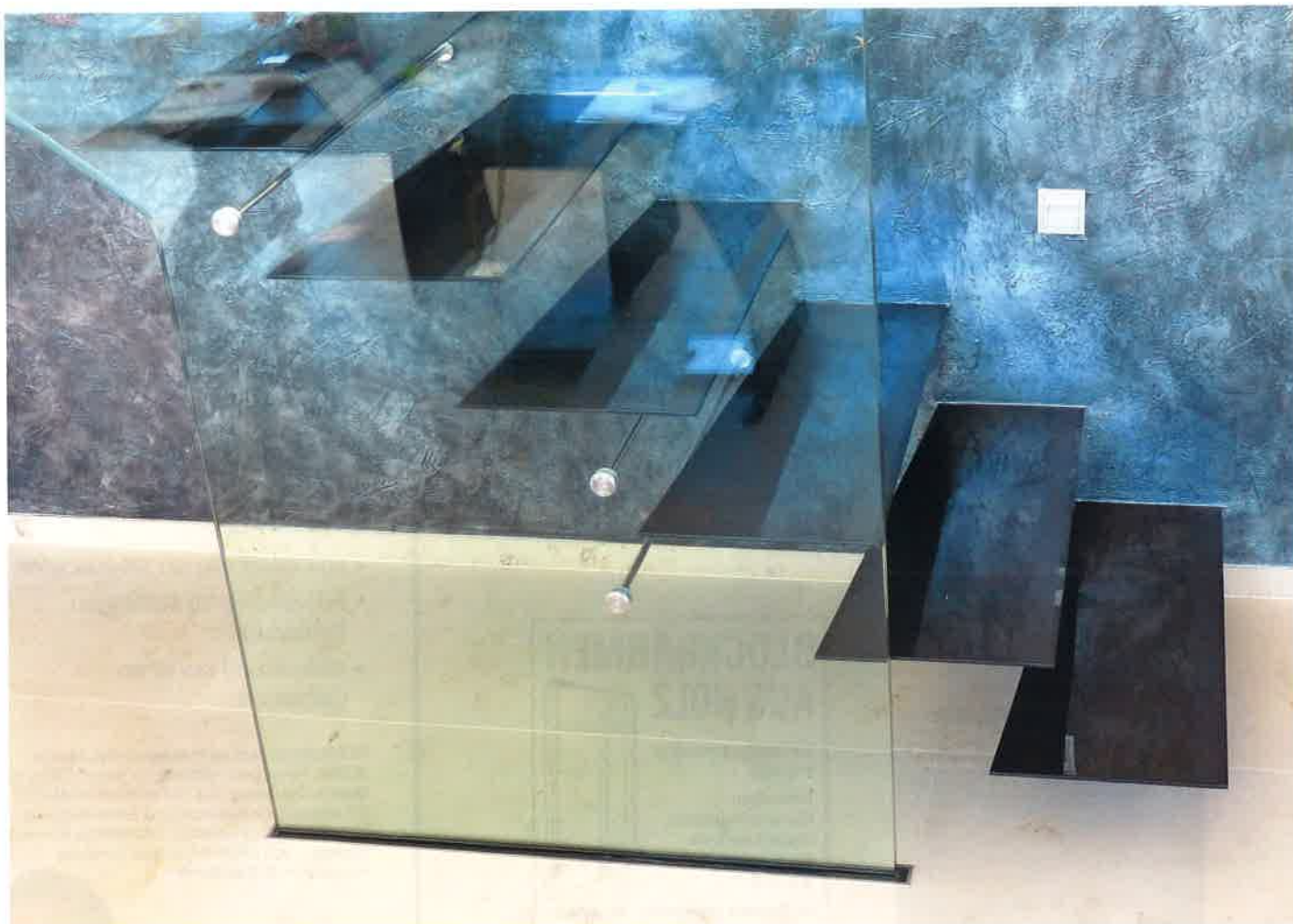
/ Filigraner Aufstieg: Lediglich 6 mm stark sind die Stufen der Kragarmtreppe aus Carbonfasern an den Kanten.
